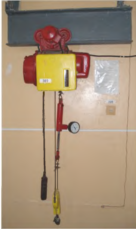
Рисунок 12.1 – Электротельфер и схема подвеса груза
